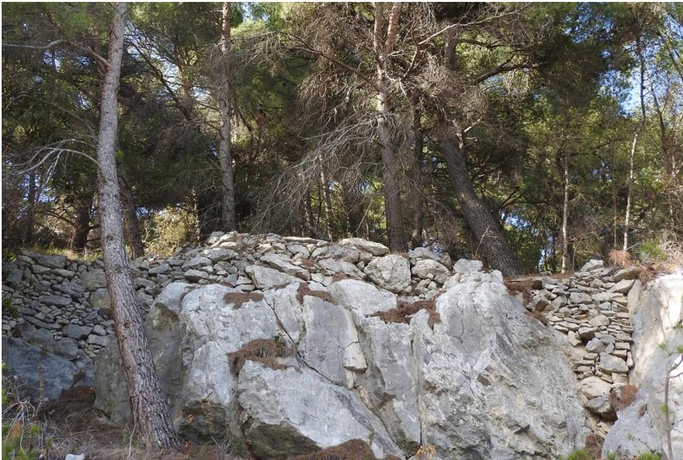
Fotografije 3-3: Sprječavanje erozije izgradnjom različitih oblika suhozida (tzv. džepnih terasa)
